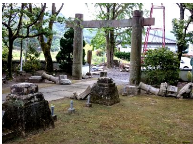
倒壊の危険を防ぐため、上部がクレーンで下ろされました。
