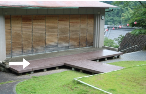
痛んでいた舞台袖の板が、新しく付け替えられました。
