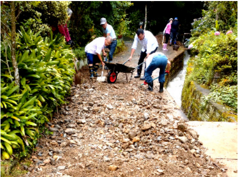
道路いっばいに流出した土砂をみんなで片付け
