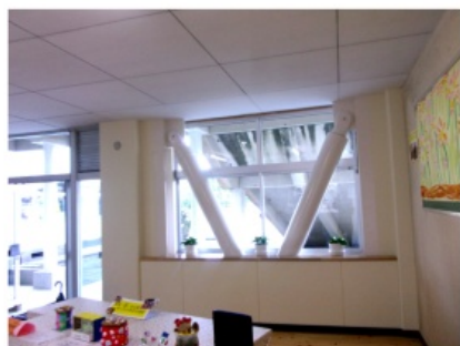
大きな鉄柱が筋交いに校舎を支える耐震工事箇所
