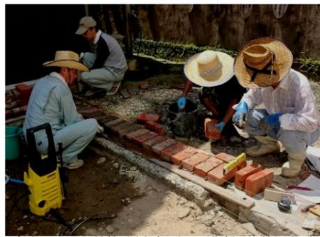
土台のレンガ積みは水平、間隔を正確に作業
