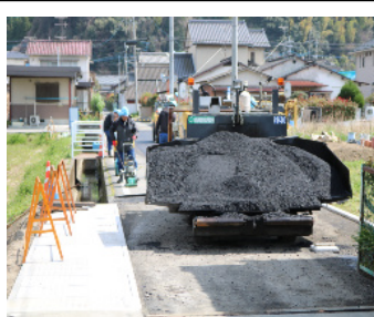
道路の拡張と整備
