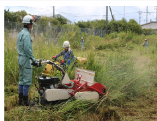
機械を使って進む除草作業
